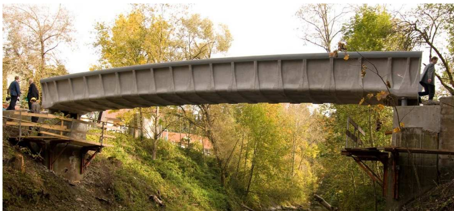
Obrázek 2: Most z textilního betonu v Kempten (Allgäu), délka 17 m, výroba laminováním a střikáním.
