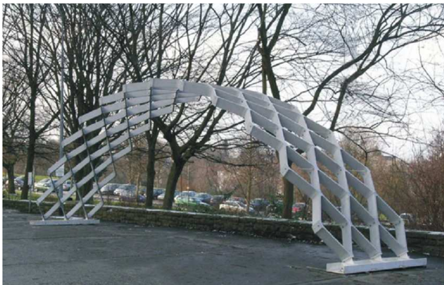
Obrázek 1: Prototyp konstrukce z textilního betonu (Aachen). [4]
